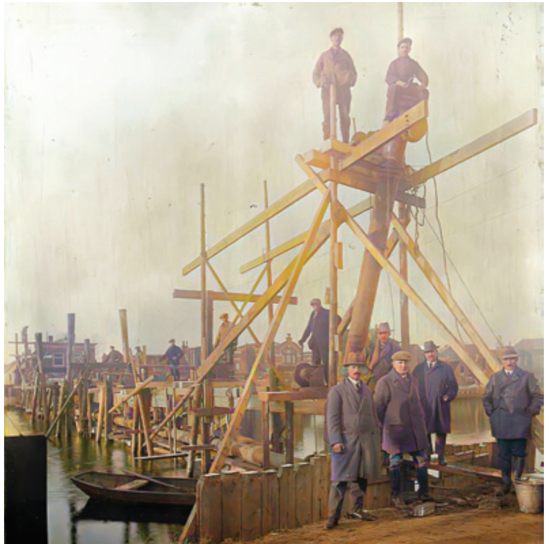
Aanleg van de zinker van de gasfabriek onder de Gouw naar de Zuidkade vanaf het Jaagpad ca 1910 met werklieden.
